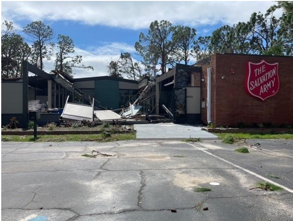
Imagen 1-5. Daños del huracán Ian a las instalaciones del Ejército de Salvación del condado de Sarasota en North Port 6
