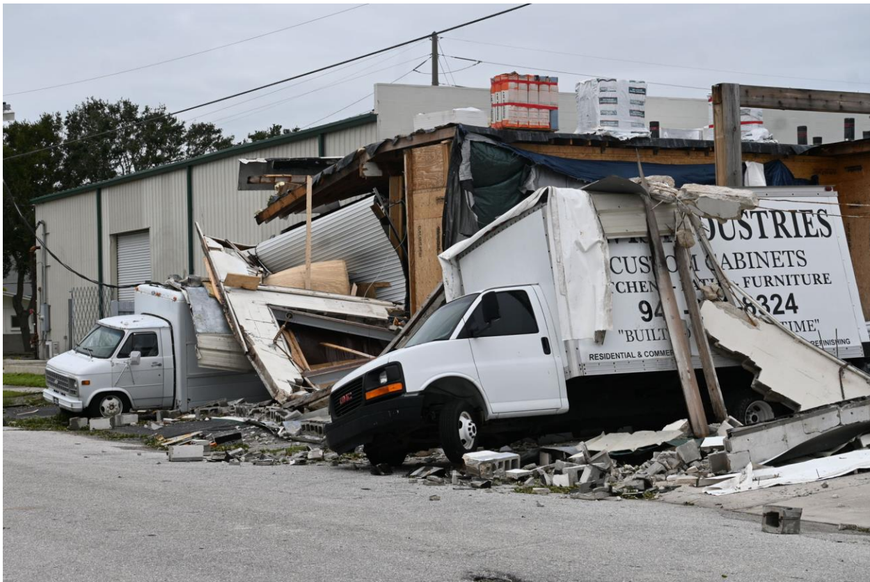
Imagen 1-9. Daños causados por el huracán a negocios en el condado de Sarasota 10
